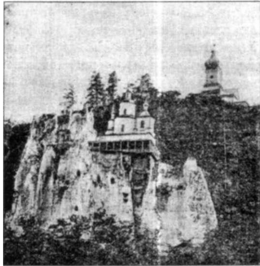
Рис. 159. Церковь на меловой скале в Святогорском монастыре. В скале видны окошки из пещер
