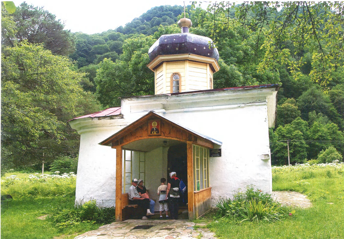
Южный храм. Северный фасад и вход
