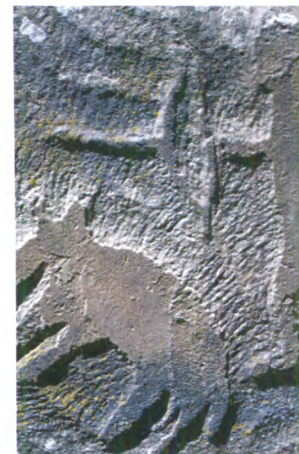
Северная стена. Фрагмент
