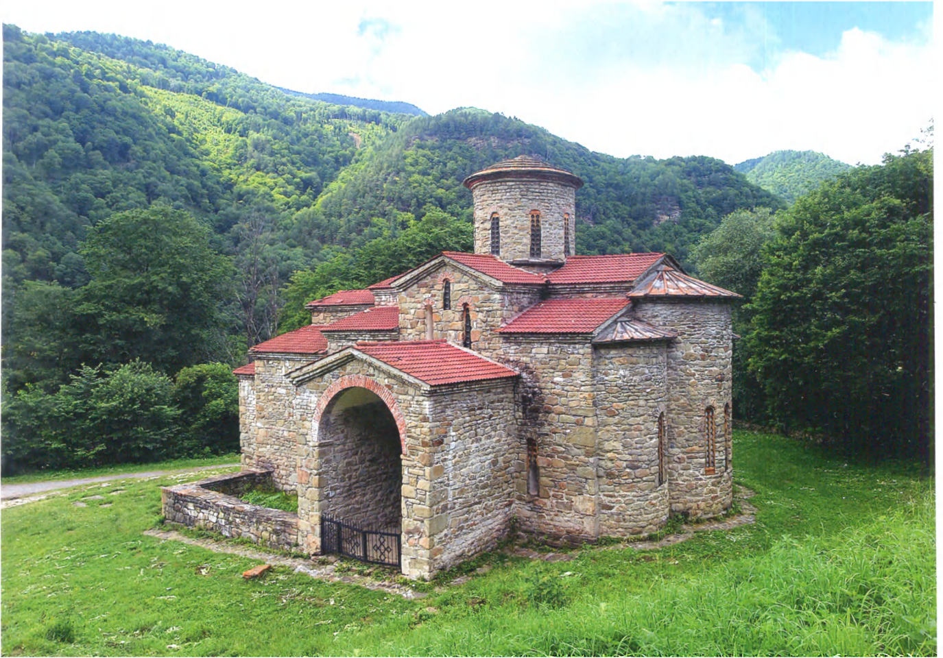
Северный храм после реставрации
